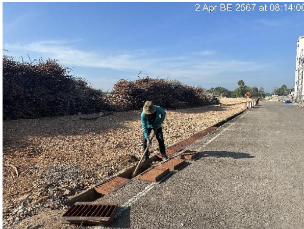
รูปที่ ข.1-27 การตรวจสอบและขุดลอกรางระบายน้ำ
