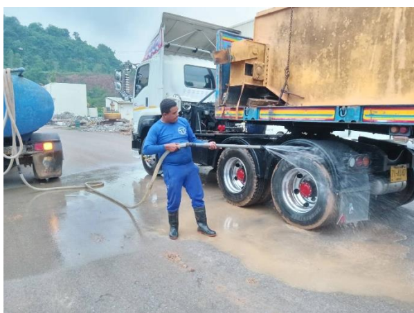
รูปที่ ข.1-5 การล้างล้อรถก่อนออกจากพื้นที่โครงการ
