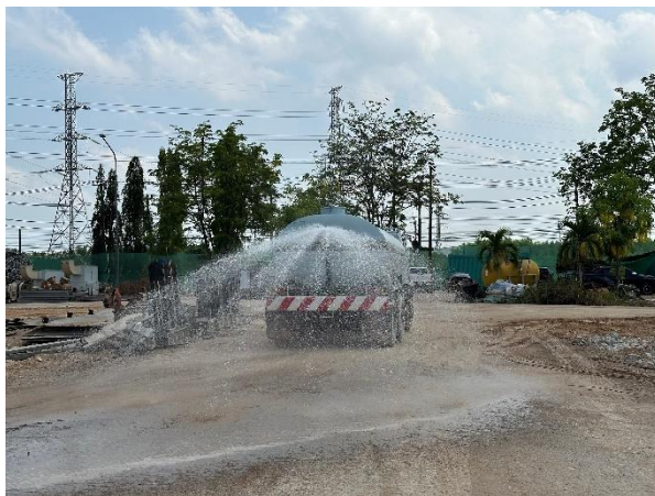
รูปที่ ข.1-2 การฉีดพรมน้ำในบริเวณพื้นที่รื้อถอน
