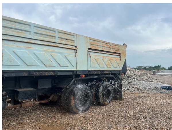
รูปที่ ข.1-5 การล้างล้อรถก่อนออกจากพื้นที่โครงการ
