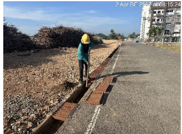
รูปที่ ข.1-27 การตรวจสอบและขุดลอกรางระบายน้ำ
